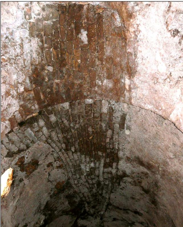
**Fig. 10 :** Vue du plafond: à droite il est en roche pleine, au centre, la maçonnerie comble le hiatus rocheux.
